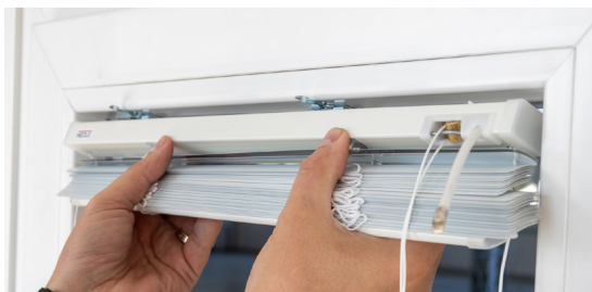
Vstavite v nosilce zgornji profil žaluzij.
